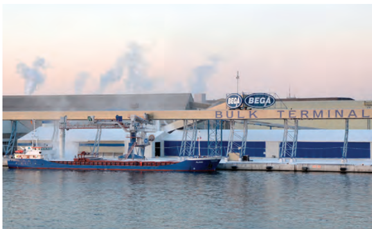
Fig. 6 : Le terminal vraquier BEGA de Klaipeda
